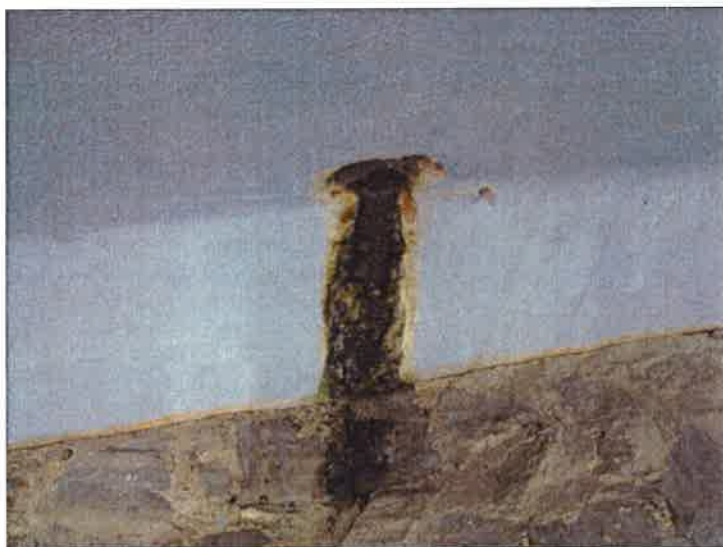
odlupování nátěru. Na ocelové výplni lokálně koroze.
