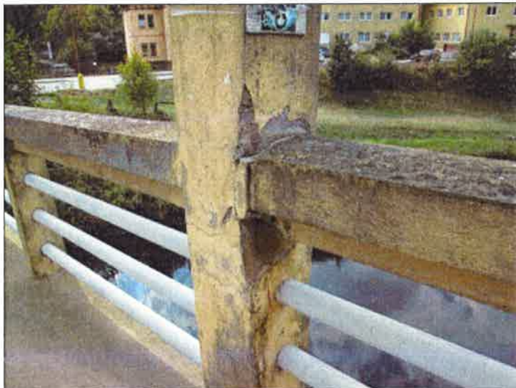
odlupování nátěru. Na ocelové výplni lokálně koroze.
